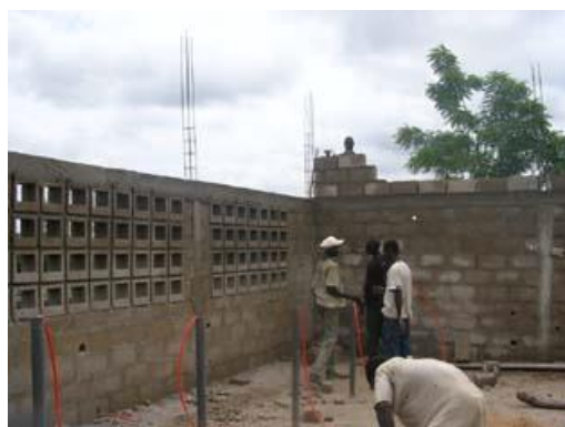
Le chantier le 12 juillet 2006 (photo Madelinh B)
