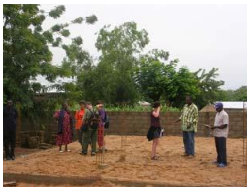
Le chantier le 27 juillet 2006 (photo Clémence N)
